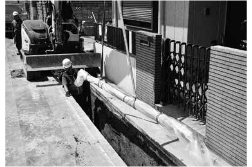
水道耐震化工事の様子
