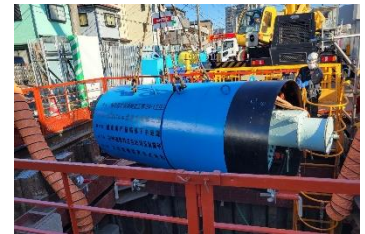
6年度に実施した下水道管路工事
