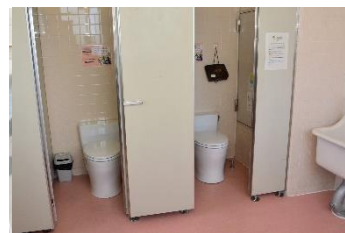
5年度に改修したトイレ(西小学校)
