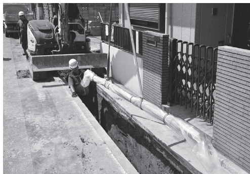
水道耐震化工事の様子
