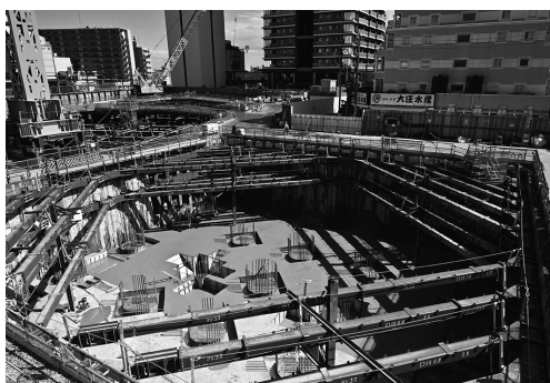
着々と工事が進む蕨駅西口再開発事業
