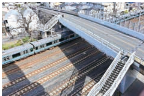
改修が進む塚越陸橋
