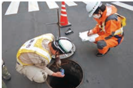
2月に下水道の緊急点検を実施
