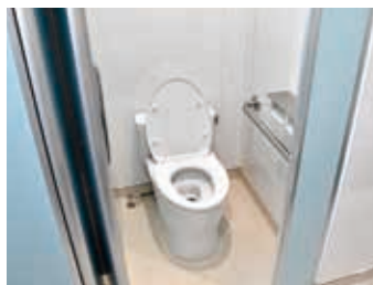
改修済みの学校トイレ（上＝塚越小学校 下＝第二中学校）
