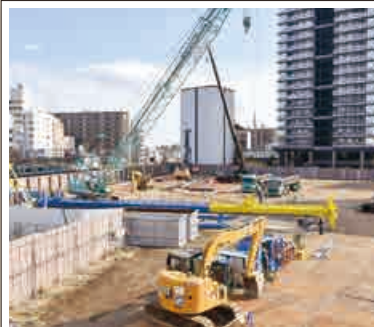
③蕨駅西口再開発事業 第2工区着工
