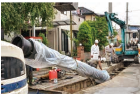
耐震化工事が行われている配水管
