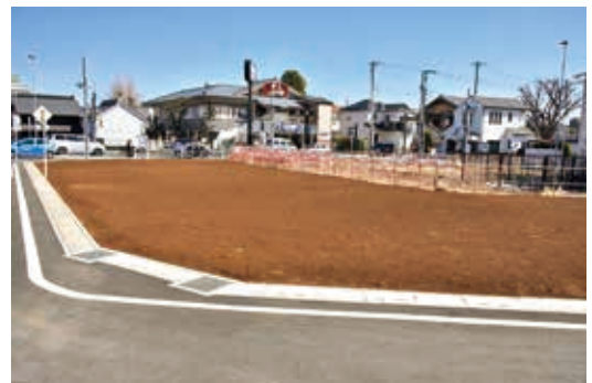
着実な推進を図る錦町土地区画整理事業(写真は道路や宅地の整備が完了した錦町3丁目の一街区)
