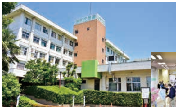
◀昭和45年に建設された市立病院
