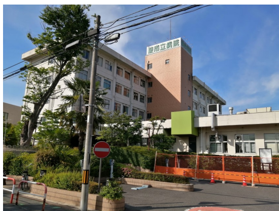
蕨市立病院の外観
