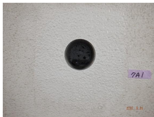
↑コア抜き後の壁面
