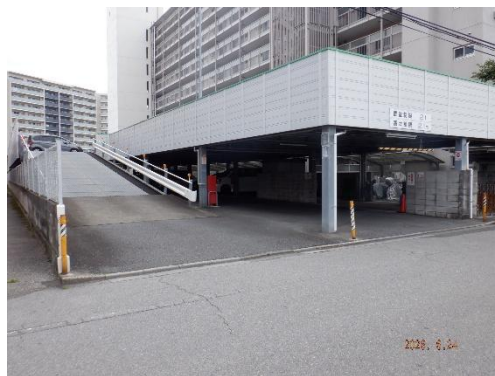
↑増設した駐車場
