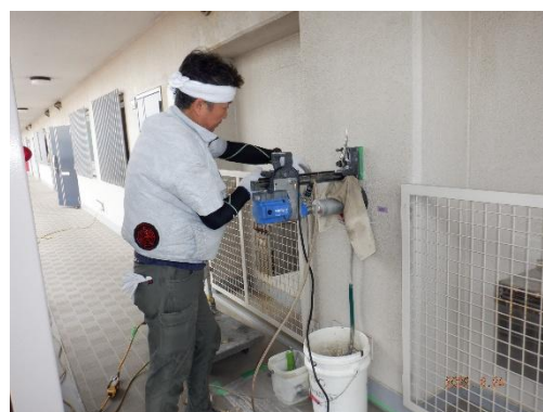
↑コンクリートのコア抜き作業の様子
