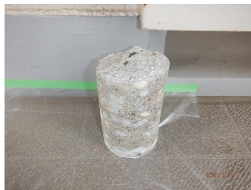
↑抜き出したコンクリート
