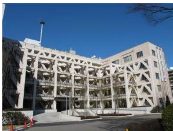
↑ブレース補強後の建物（埼玉県庁）
