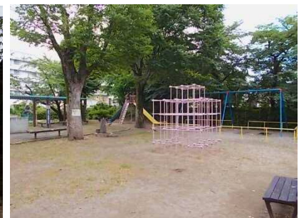
経年劣化を感じる遊具（トイレあり）
