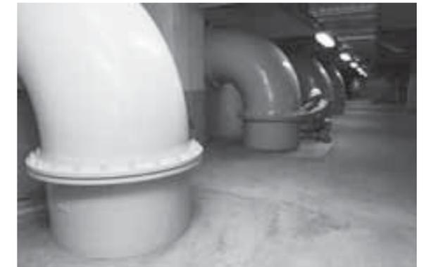
直径約1mの4本の管で雨水を放流(南町ポンプ場)
