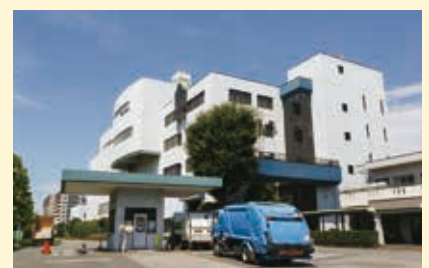
蕨戸田衛生センターの外観
