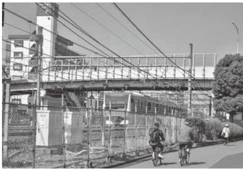
計画的に橋りょう改修事業を実施(写真は塚越陸橋)
