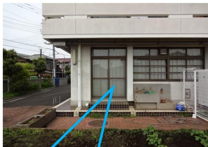
1階防災資料室入口
