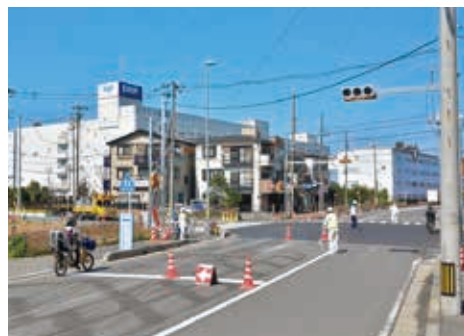
錦町区画整理事業を着実に推進します(わらびりんご通りに信号機設置)
