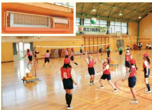
北小学校(写真)と中央小学校の体育館にエアコンを設置
