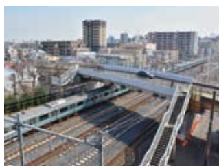
第一中学校の北側にある塚越陸橋
