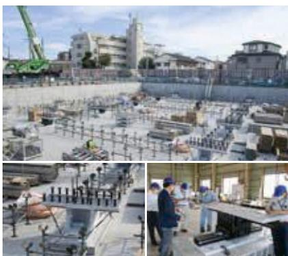
▲高度な耐震性能を備えた安全な庁舎にするため、免震装置を取り付けました(6月)
