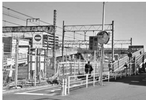
耐震診断を実施する蕨跨線人道橋
