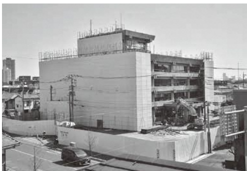
建替えに向けて解体が進む旧庁舎
