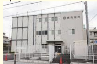
仮設庁舎の外観
