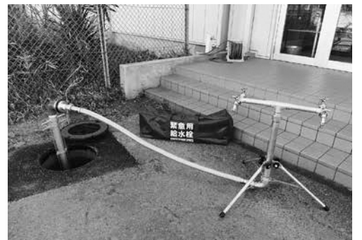
小・中学校の敷地内に整備する災害用応急給水栓
