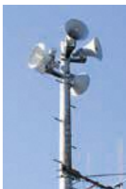
▶防災行政無線を更新(写真は現在の機器)
