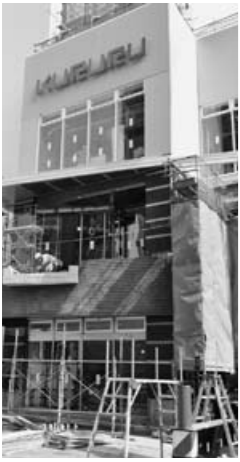
▲10月完成予定の公共公益施設「くるる」
