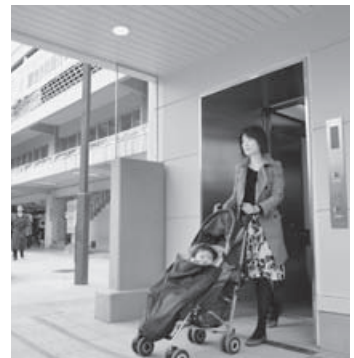
▲駅西口に設置されたエレベーター
