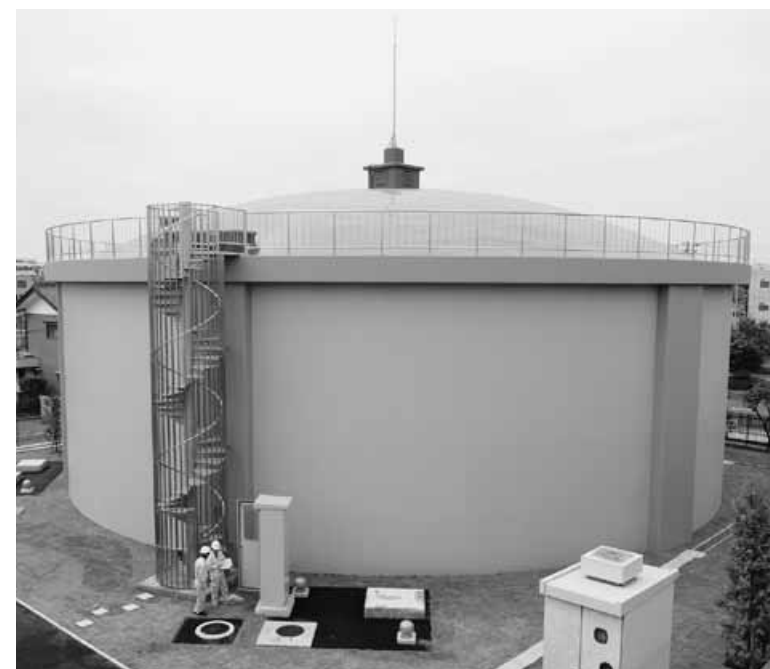
中央浄水場南側に設置した地上式配水タンク
