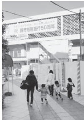
3月に完成の蔵駅西口エレベーター。東口は22年度中に竣工
