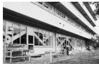
▲全小・中学校校舎の耐震化完了（写真は中央東小学校）
