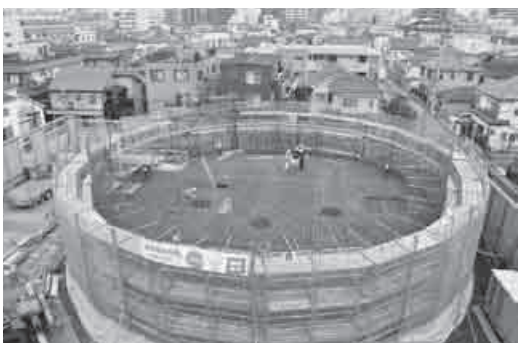
北町一丁目雨水調整池築造工事の様子(2月16日)
