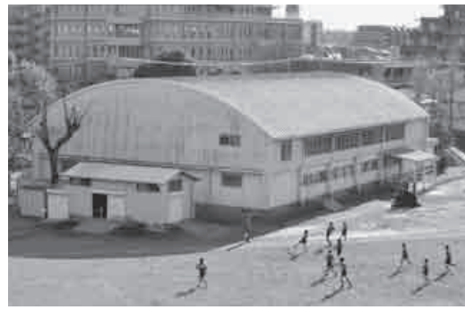
小学校4校の体育館耐震化工事を実施(東小学校)
