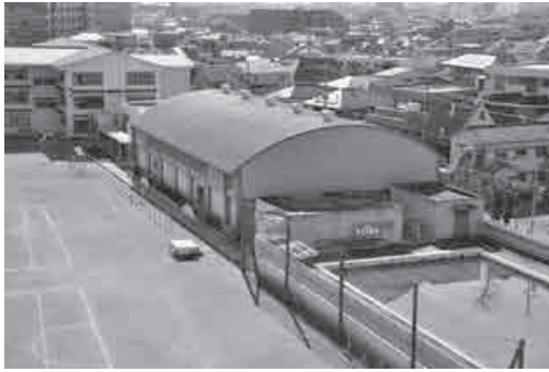
今年度で全学校体育館の耐震化が完了 (北小学校)
