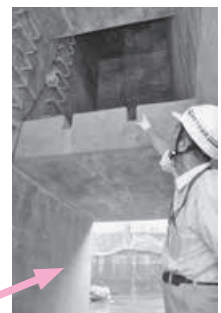
▲雨水が流れ込む経路に段差を設けることで、落下時の衝撃を緩和できる構造になっています
