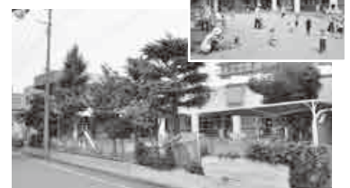
耐震化工事を終えた、みどり保育園
