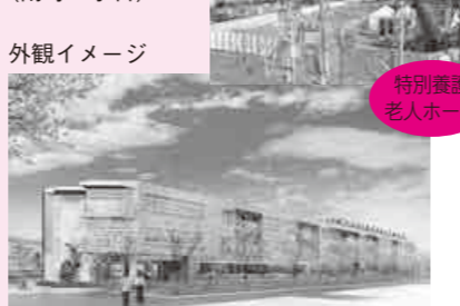
整備が進む特別養護老人ホーム(南町2丁目)
