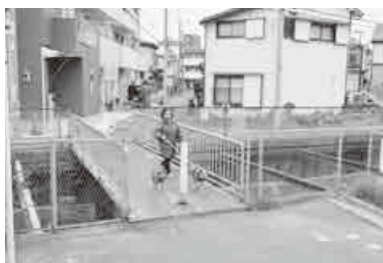
架け替え工事をを行う一中協の緑川人道橋
