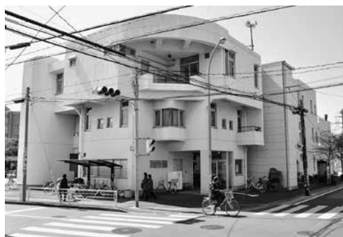
東公民館(写真)と南公民館の耐震補強工事を実施
