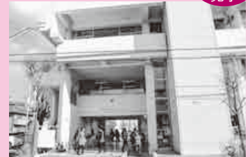
25年度に東・西・南公民館で耐震診断を実施。診断結果に基づき、今年度に東・南公民館で着工し完了
