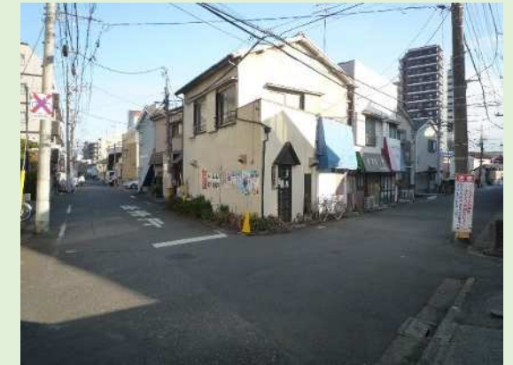
① 区画道路16号 A【整備前】
