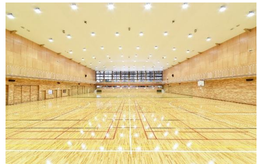
▲空調設備を整備する市民体育館アリーナ
