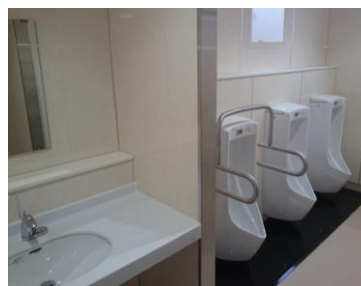
改修後（二中体育館トイレ）
