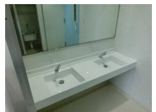
▲改修後のトイレ(東中)
