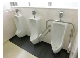
▲改修後のトイレ(西小)
