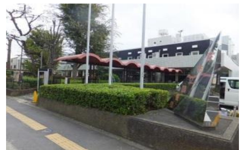
▲耐震補強工事を実施する図書館
