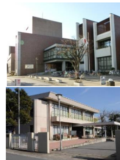
◀ エレベーター設置工事を行う中央公民館（上写真）と西公民館（下写真）
