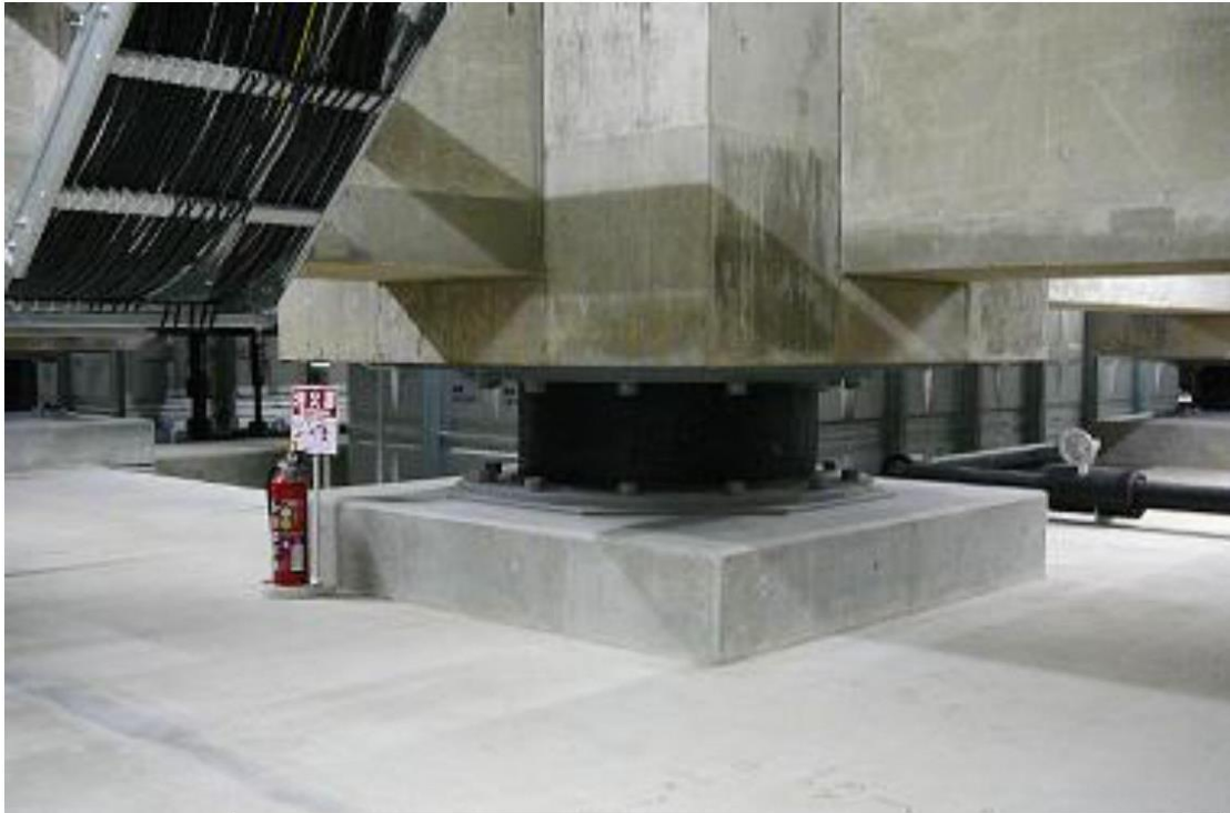
免震構造の採用 福島市庁舎 (越谷市本庁舎建設基本計画より)
