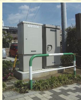
写真 ① 自動水質監視装置
