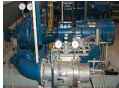
配水ポンプ改修前
