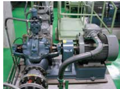
配水ポンプ改修後
