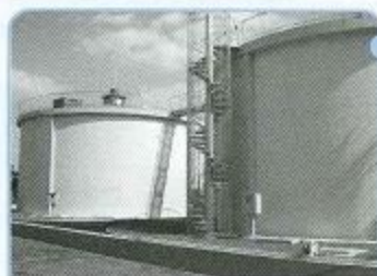
No.1配水池(右)
