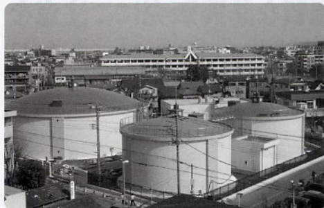
3つの配水池が出来上がり、まもなく完成となる塚越浄水場
