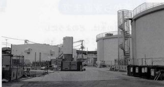
3基の配水池のうち、2基が完成した塚越浄水場
