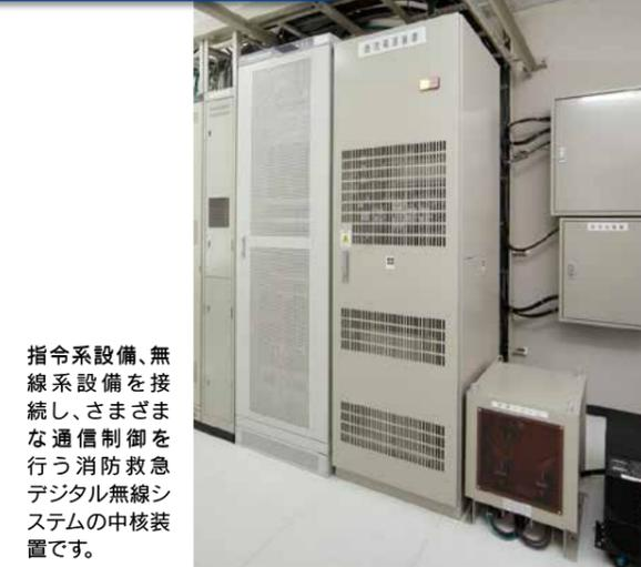
指令系設備、無線系設備を接続し、さまざまな通信制御を行う消防救急デジタル無線システムの中核装置です。
