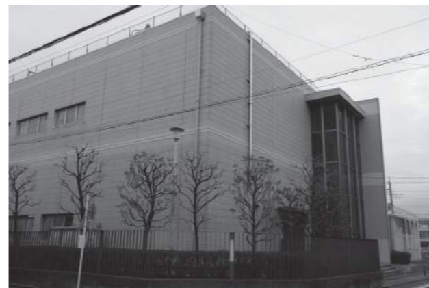
南町ポンプ場
