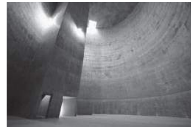
わらび公園地下にある雨水調整池
