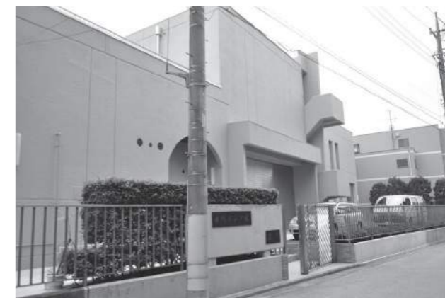
塚越ポンプ場
