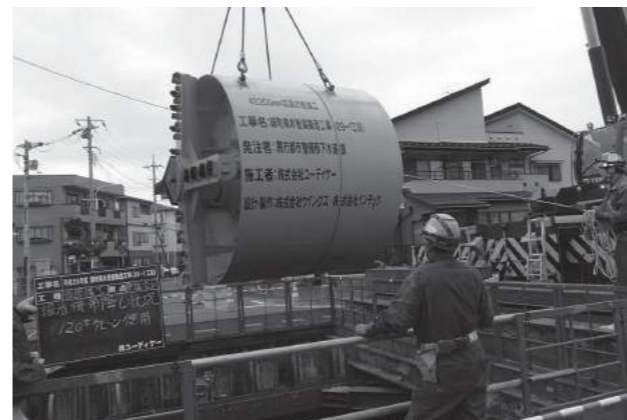
錦町地区の雨水管工事（推進機・吊り下げ）
